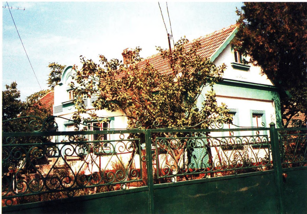
Die Nachbarhäuser von Christian Klatt in gutem Zustand, innen wie außen Foto: I. Warth
